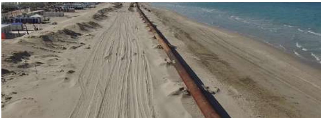
FIGURA 11 Riccione: sabbiodotto utilizzato per l'intervento di ripascimento con sabbie sottomarine (2016).
