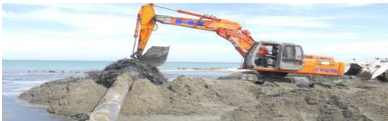
FIGURA 12 Lido Spina Sud: operazione di ripascimento realizzato nel 2016 con il sedimento prelevato alla foce del canale Logonovo.
