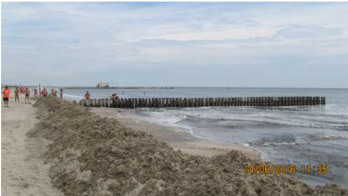
FIGURA 140 Milano Marittima Colonie (cella 61): pennello in pali di legno (14/06/2016).
