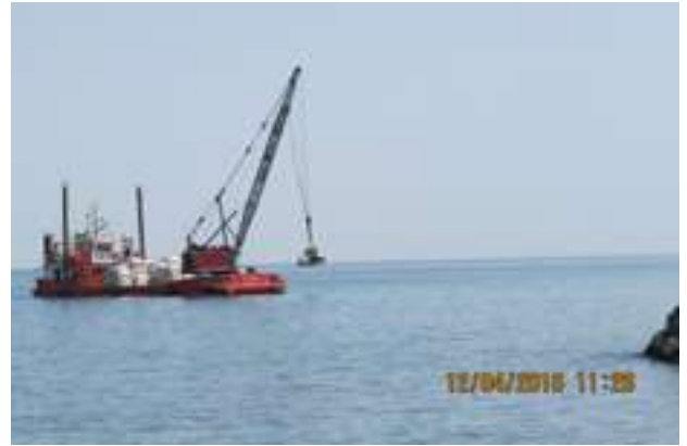
FIGURA 112 Riccione: operazioni di ricarica della barriera in sacchi piena di sabbia.
