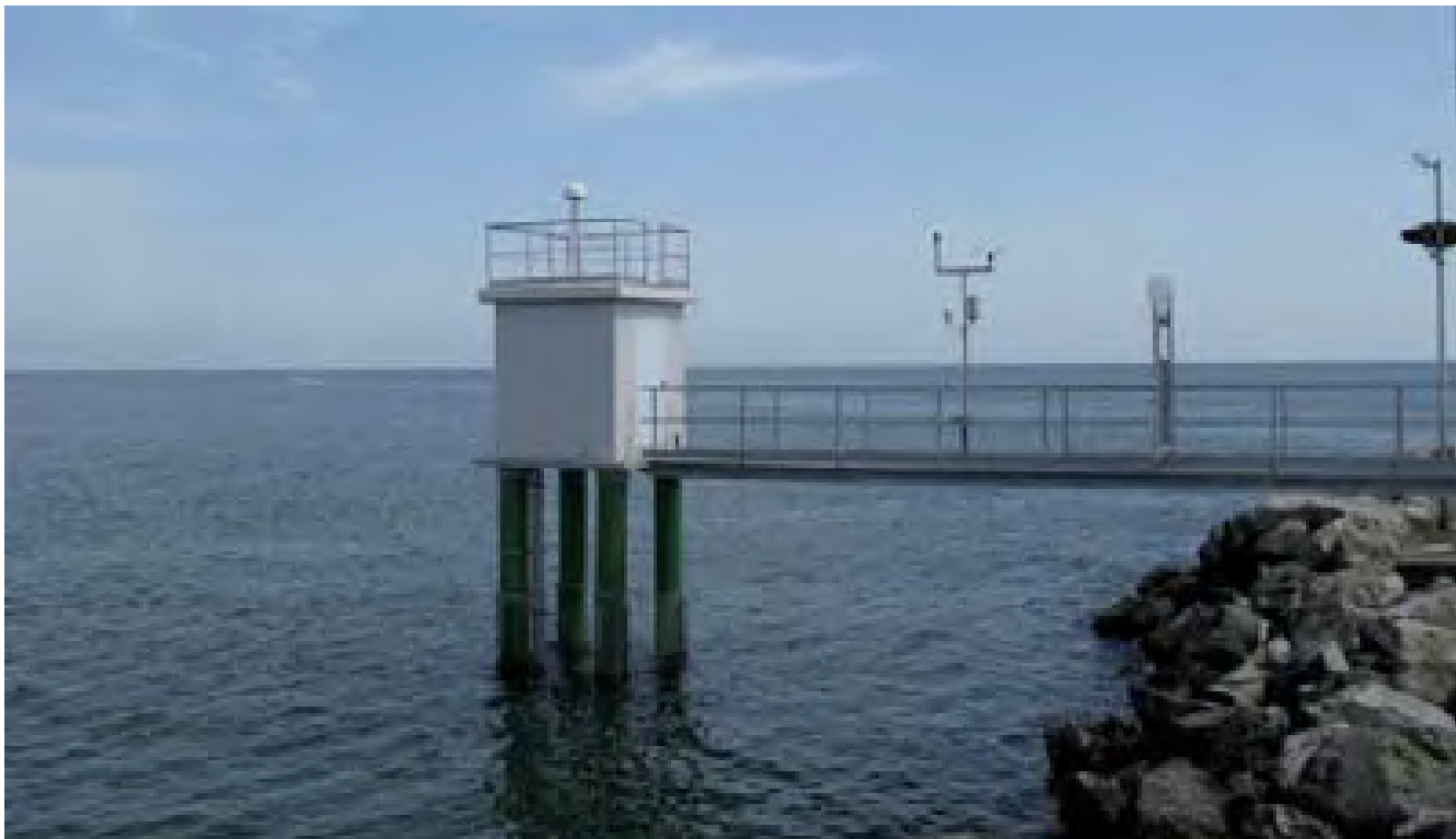
FIGURA 28 La stazione mareografica di Porto Garibaldi collocata in prossimità della testa del molo Nord del portocanale.
