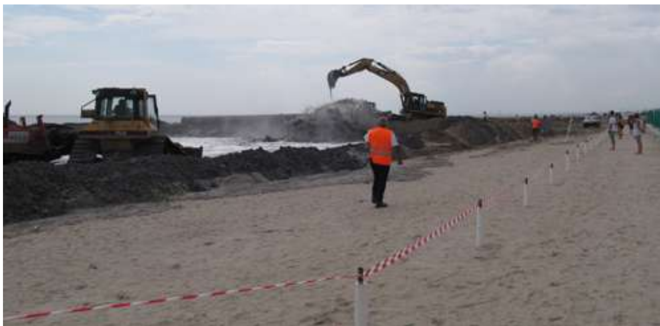
FIGURA 141 Milano Marittima: operazione di ripascimento e riprofilatura della spiaggia (14/06/2016).
