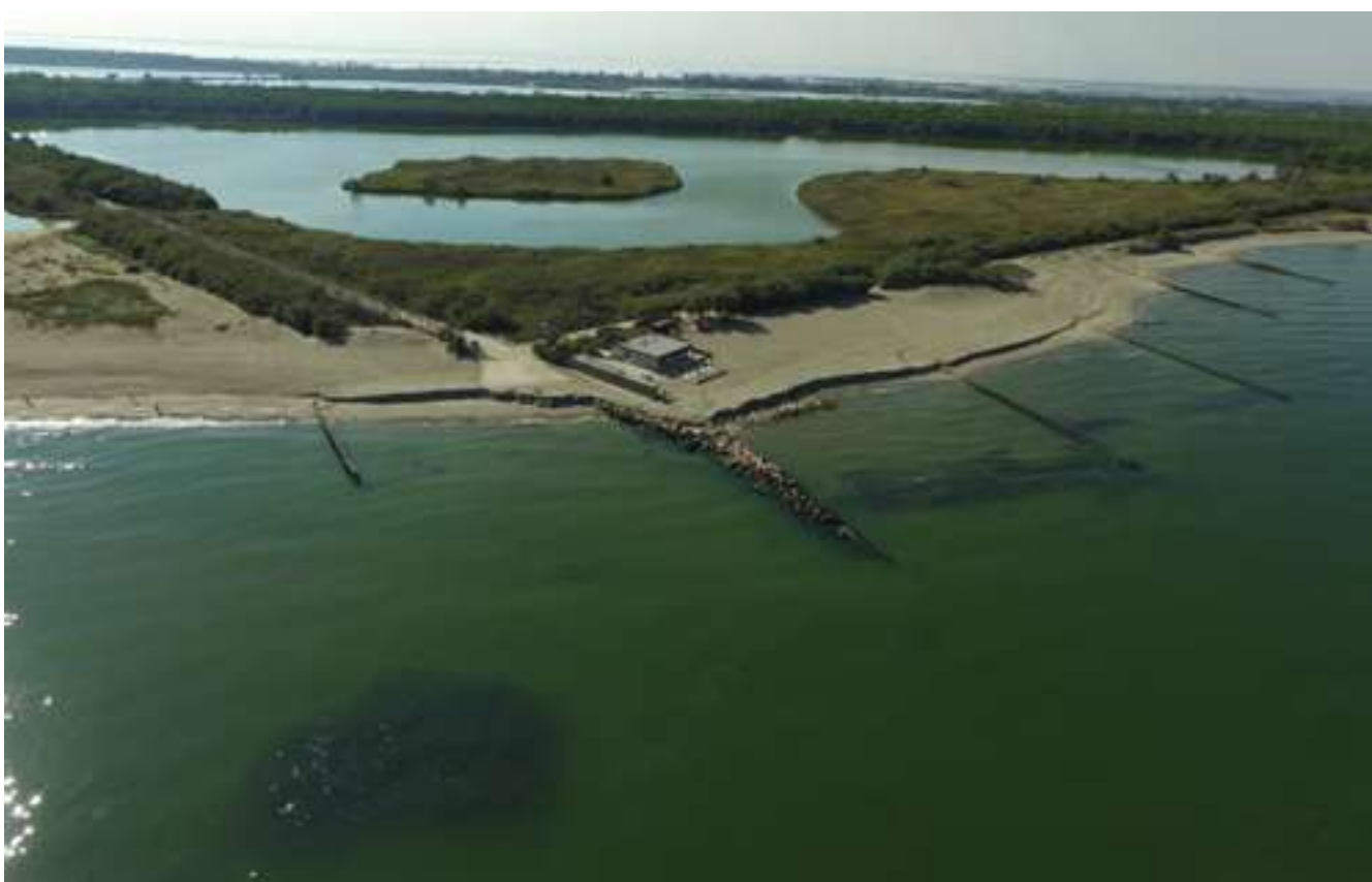
FIGURA 9 Lido di Spina Sud (Comacchio): pennelli in pali di legno e in roccia (4 ottobre 2016).
