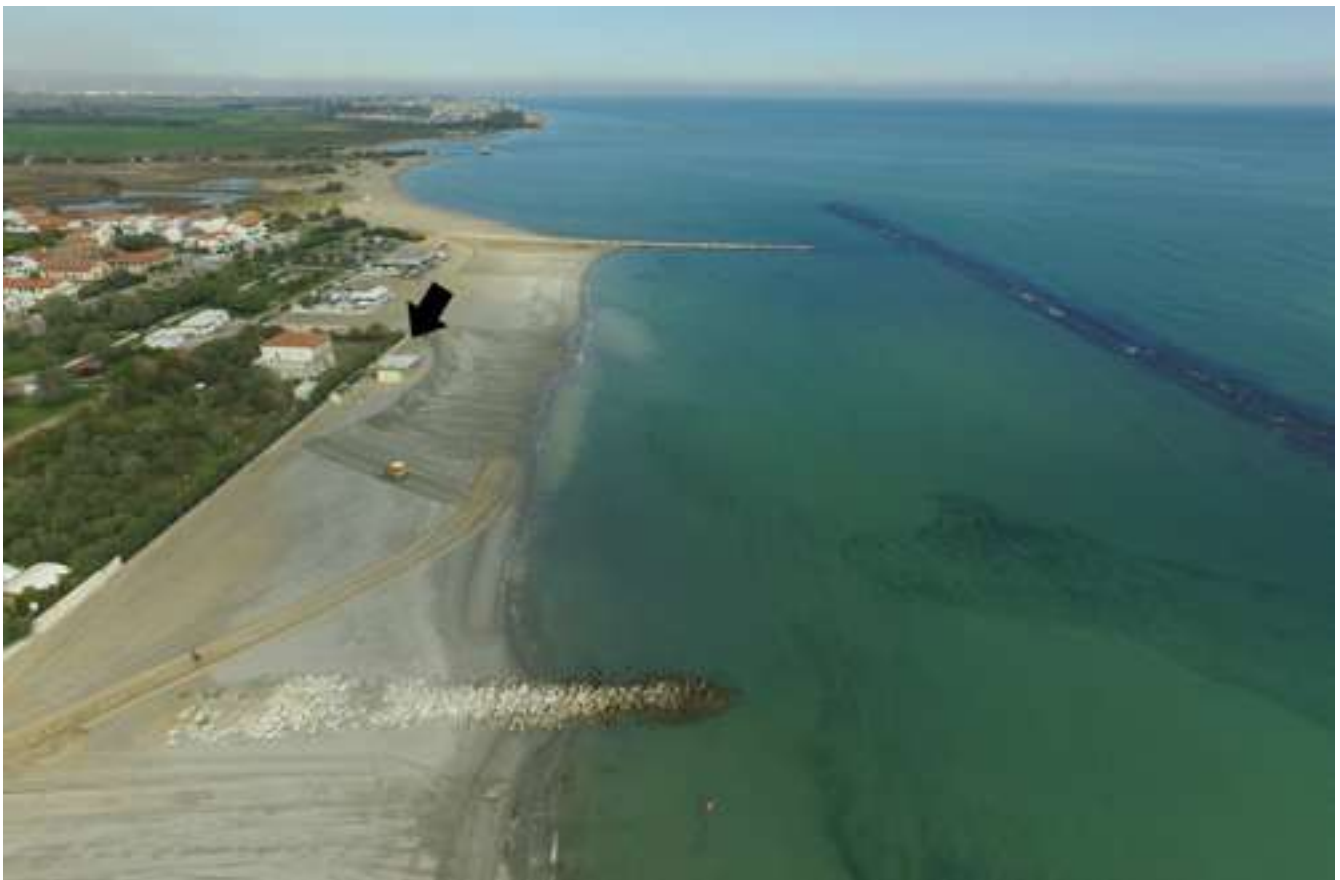
FIGURA 148 Lido di Dante (cella 72): in alto, spiaggia in erosione (Bagno Smeraldo, 5 febbraio 2014), in basso, ripristino della spiaggia in seguito al ripascimento con sabbie sottomarine (freccia nera, posizione del Bagno Smeraldo, 4 ottobre 2016).
