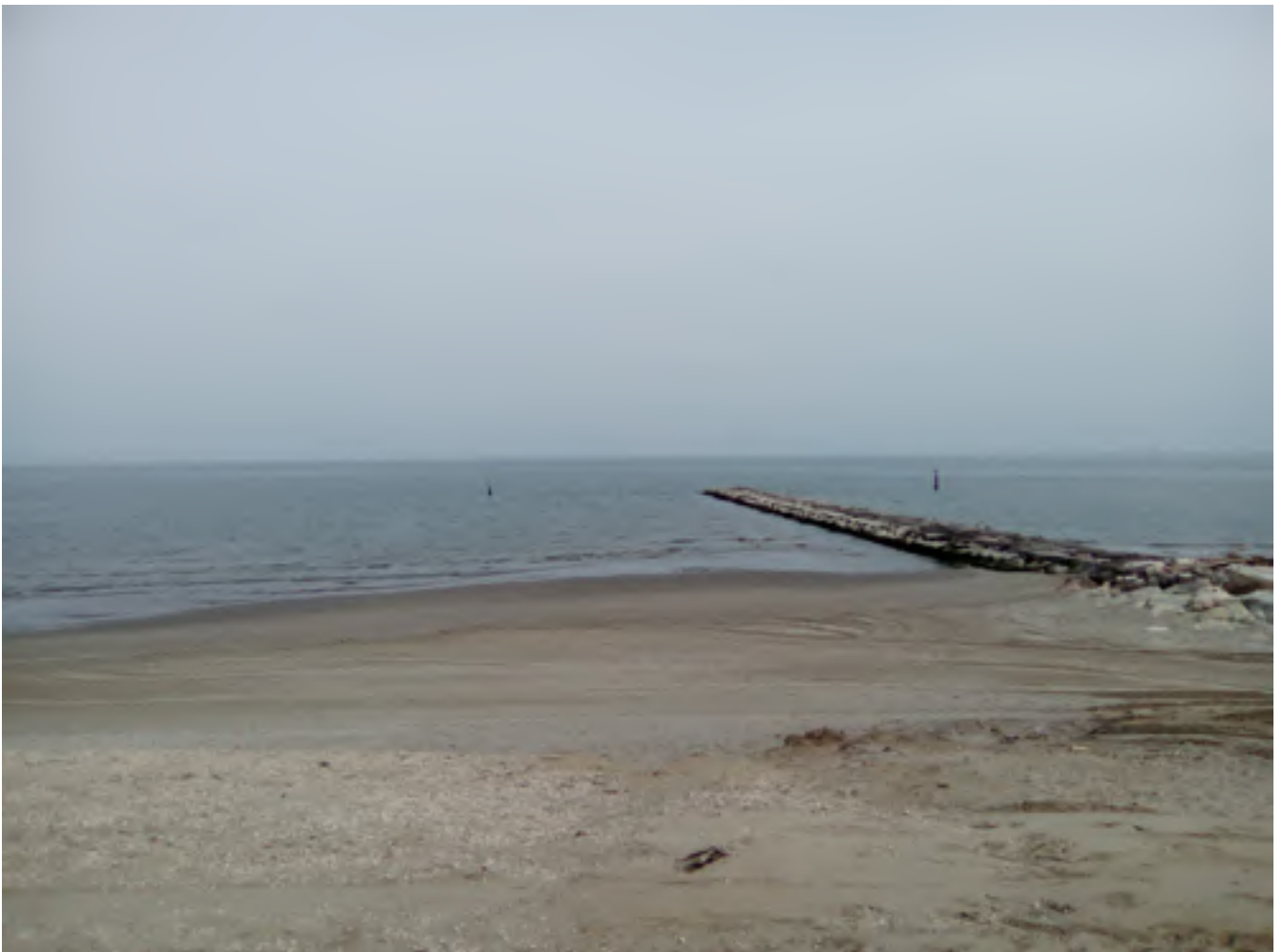
FIGURA 161 Foce Lamone-Casal Borsetti (cella 85): opere di difesa dall'erosione marina.
