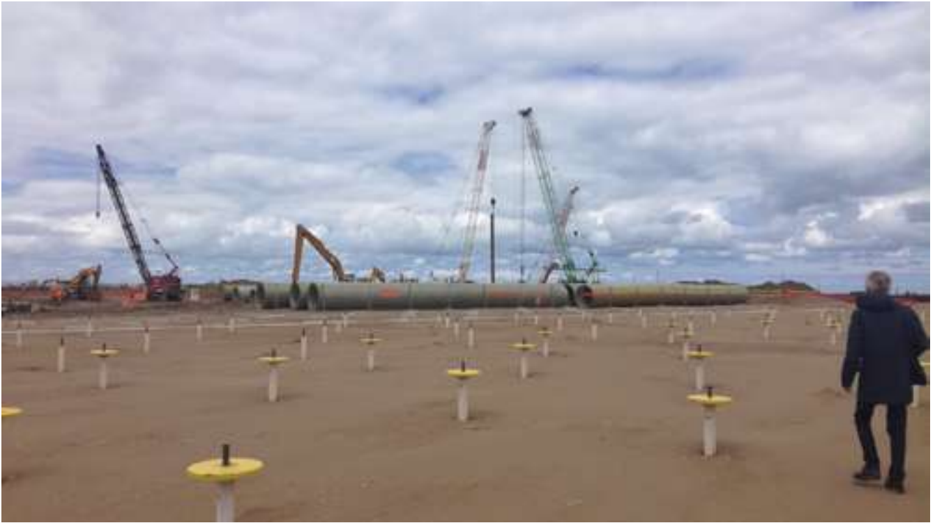
FIGURA 117 Rimini: cantiere per la posa delle condotte di scarico delle acque a mare.
